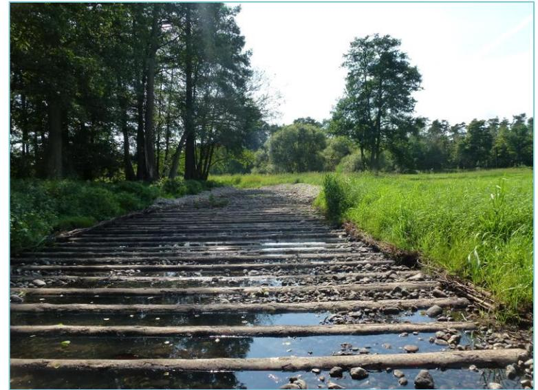
Eine ‚raue Rampe‘ hält das Wasser innerhalb des Projektgebiets auf dem eingestellten Niveau und sorgt für einen sanften Übergang zum ursprünglichen Grabenniveau (Foto: Flächenagentur Brandenburg GmbH, 2015)
