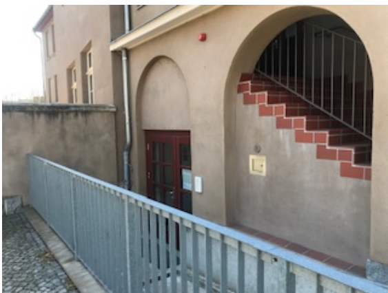
Abbildung 1: Ansicht Hauptzugang zur Erstinformationsstelle Feuerwehr (BMZ)
