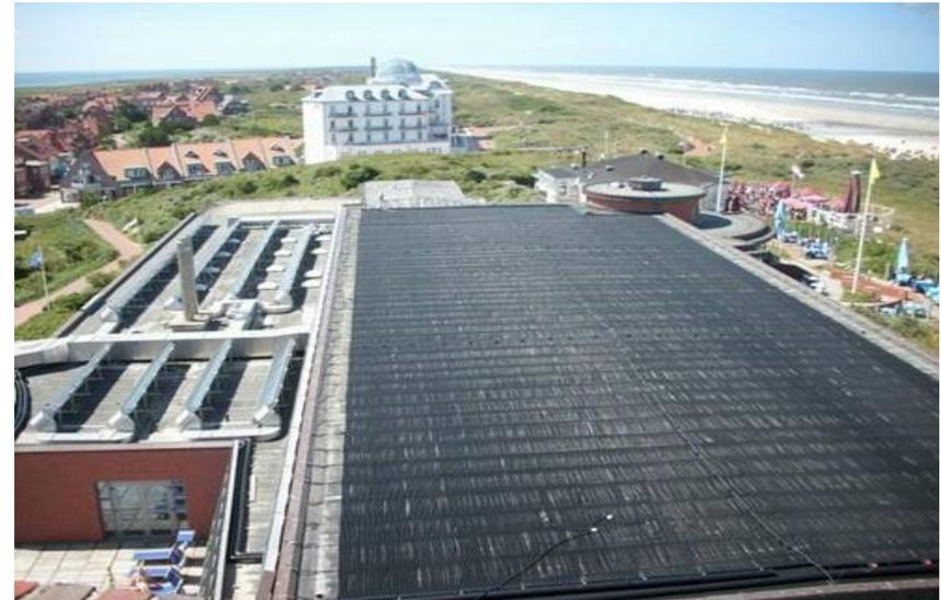
Wärmequelle: 800 m<sup>2</sup> Solarabsorber
