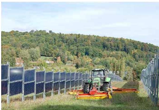
Abb. 6. Photovoltaik-Anlagenkonzept mit zweiseitig aktiven vertikal montierten Modulen, das Mäharbeiten zwischen den Modulreihen erlaubt (Quelle: Next2Sun GmbH)
